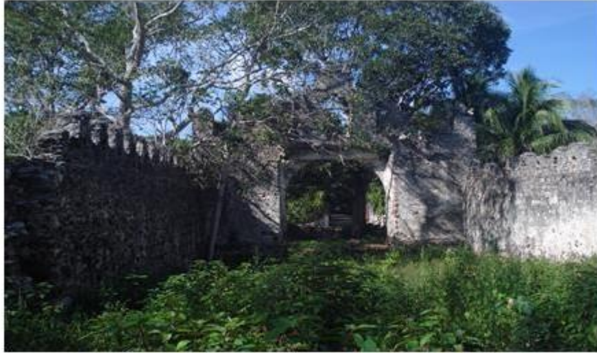
CONACULTA-INAH-MEX; "Reproducción Autorizada por el Instituto Nacional de Antropología e Historia". Planta en forma de L; vista del pórtico queda del lado de los atrios de la Iglesia del Cristo negro y de la Iglesia de San Bernardino de Siena. Fotografía de Héctor Arjona Yeladaqui
