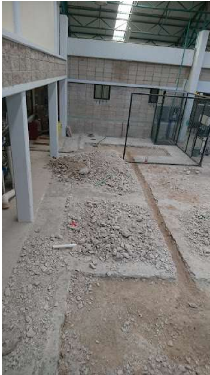
Ranurado y levantamiento de piso
