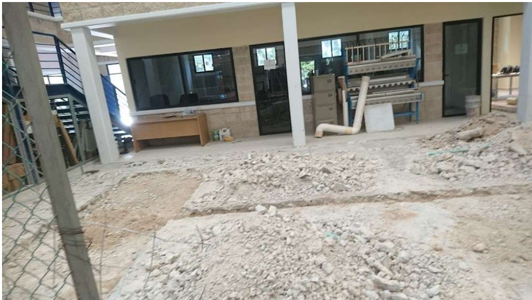
Ranurado y levantamiento de piso
