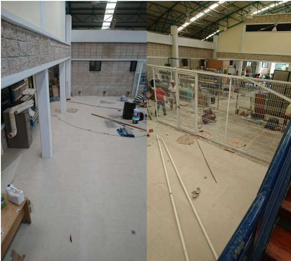
Herrería y Colocación de la cerca
