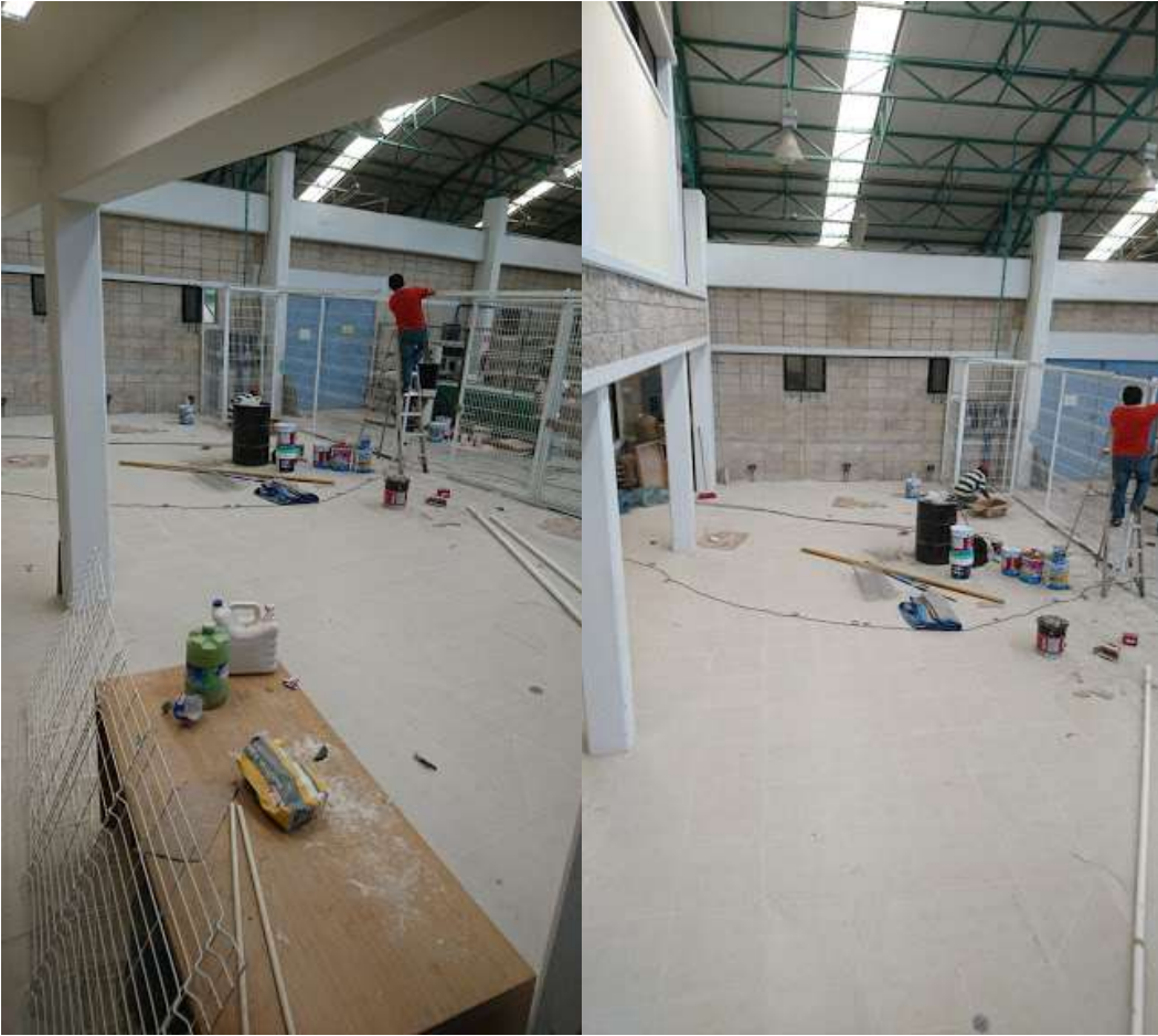
Herrería y Colocación de la cerca
