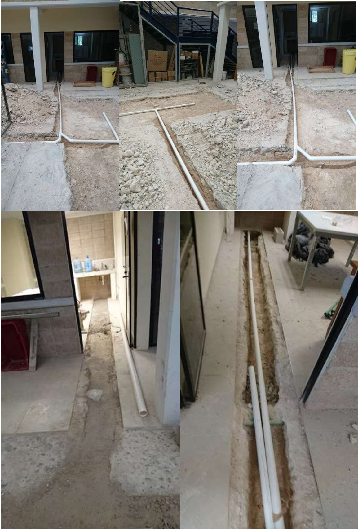
Instalación de drenaje sanitario, instalación hidráulica y cableada eléctrica
